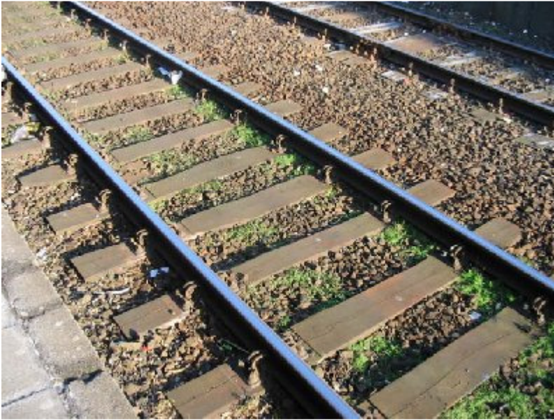
Schotteroberbau mit Holzschwellen
