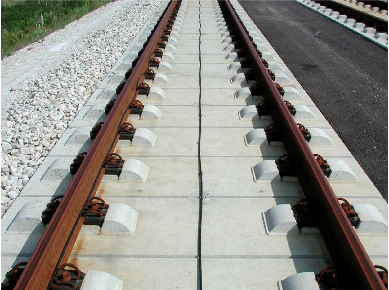
Feste Fahrbahn auf der SFS Nürnberg–Ingolstadt ; System Bögl
